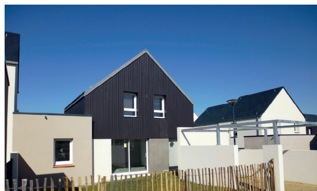
QUEVEN (56) – « Croizamus » – Architecte : D. Le Dyllo
