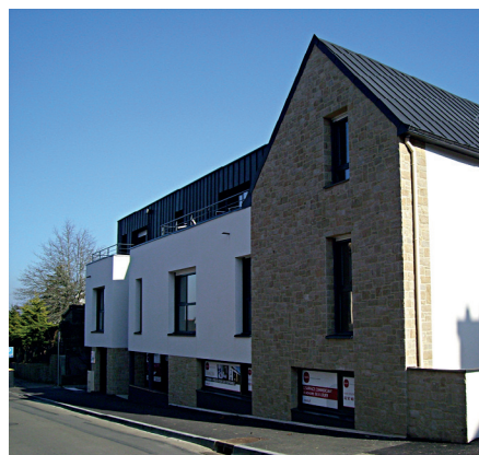
SÉNÉ (56) - Centre Bourg Architecte : VEFA Nexity
